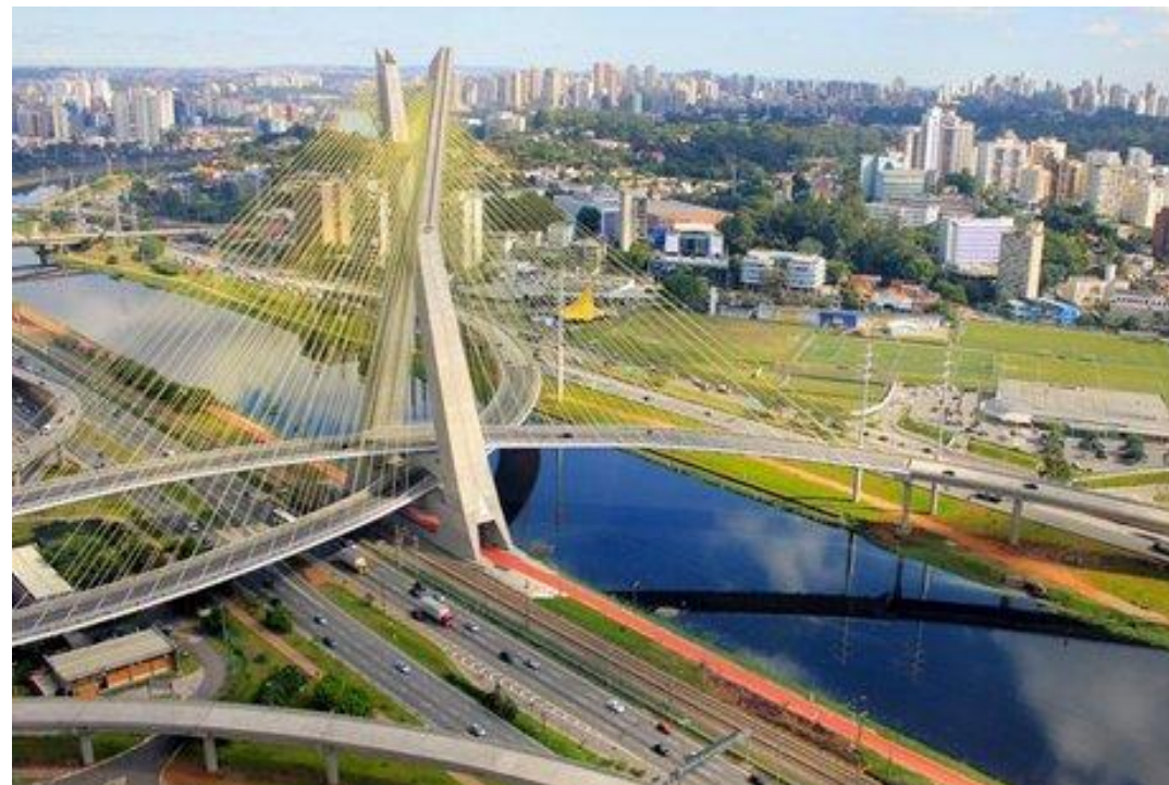
PONTE ESTAIADA SOBRE O RIO TIETÊ
