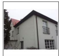
pohled z jhu - přístavba
