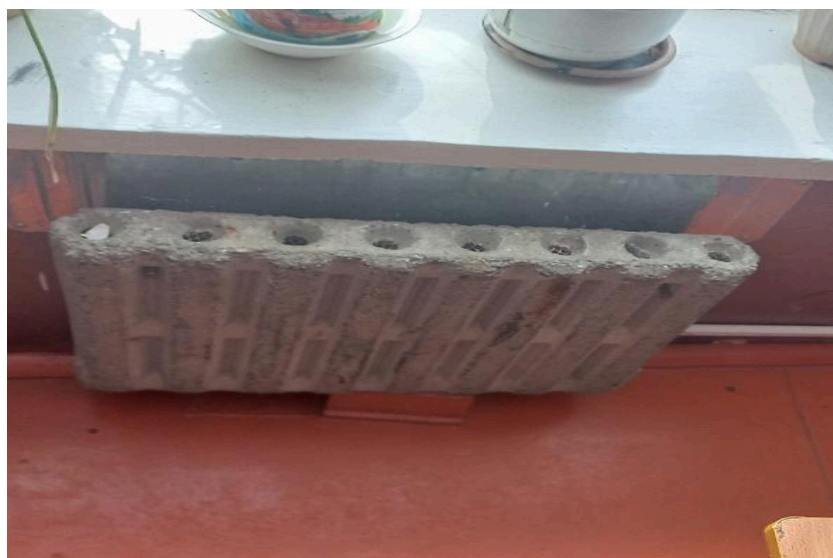
Рис.11 – Бетонные электроконвекторы.
