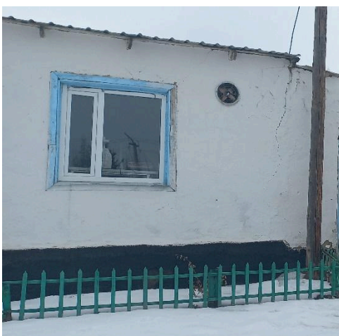
Рис.12 – Вытяжная вентиляция через стену на улицу
