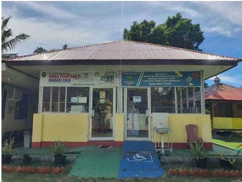
Tampak Depan Ruang PTSP Pengadilan Agama Mukomuko
