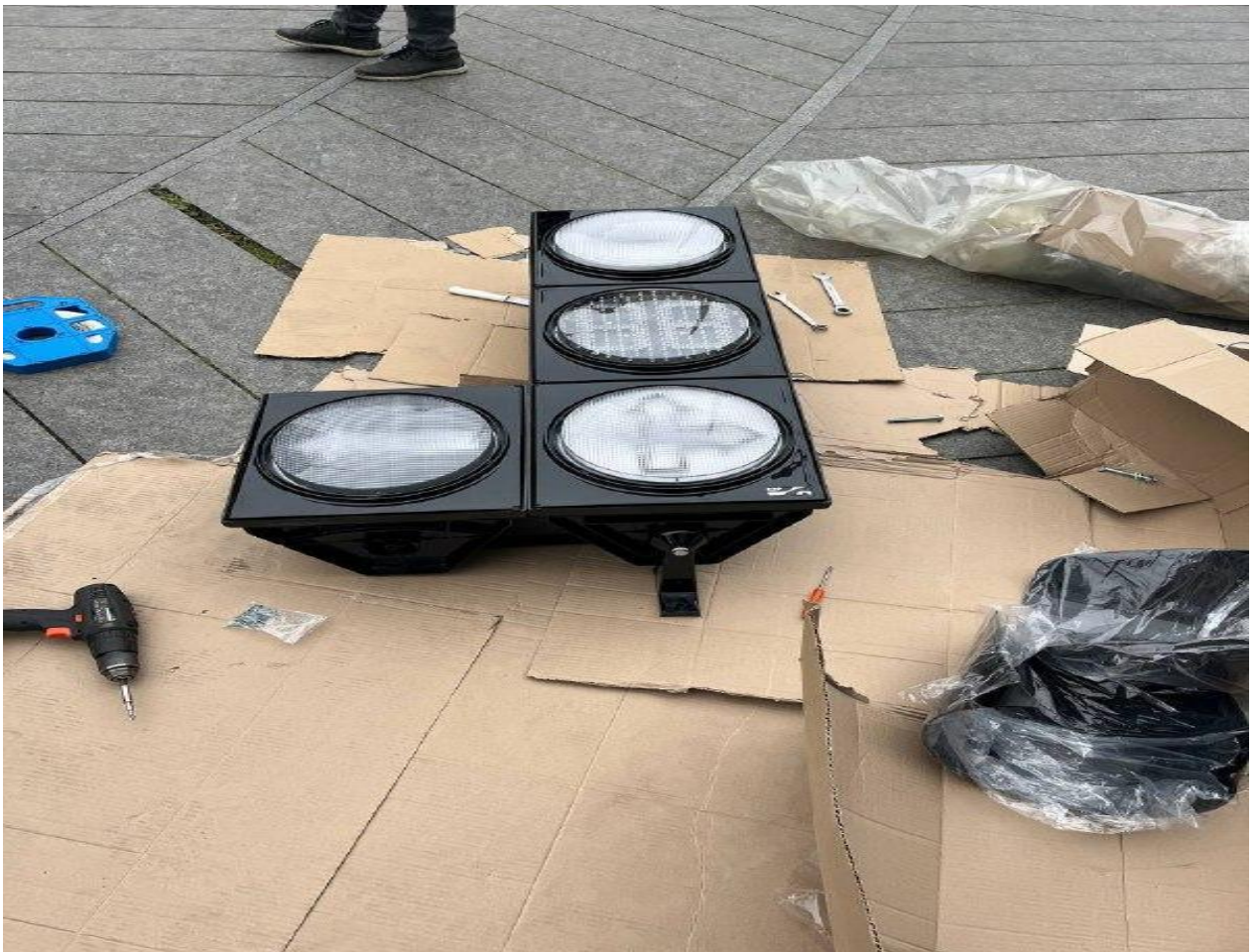
Монтаж світлофорного обладнання на перехресті Південного бульвару та вул. Бельведерської
