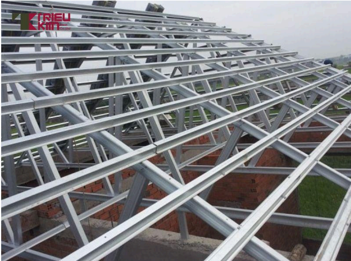
Triệu Kim-Làm Kết Cấu Chịu Lực Cho Mái Nhà
