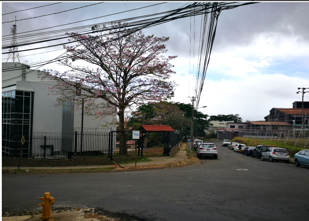
Fotografía 2. Costado este del edificio SETENA – DGM. En primer plano se observa intersección entre Av. 21-A y Av. 2, sin señalización de vial horizontal, con disponibilidad de hidrante. En segundo plano a la derecha, se muestra plaza de deportes de San Francisco de Goicoechea.
