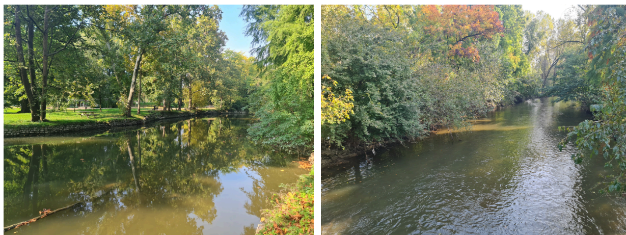
Figura 6.4 – Porzione finale del tratto 28 e vista verso valle dal ponte di via Licata
