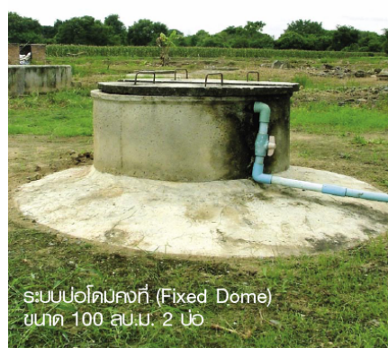
ภาพที่ 8.1 บ่อแก๊สชีวภาพแบบยอดโดม (สมชัย, ม.ป.ป.)
