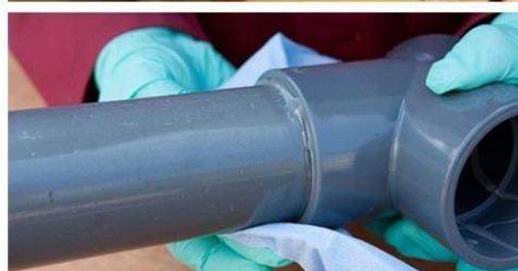
Рисунок 59 – Склеювання металевих та неметалевих деталей
