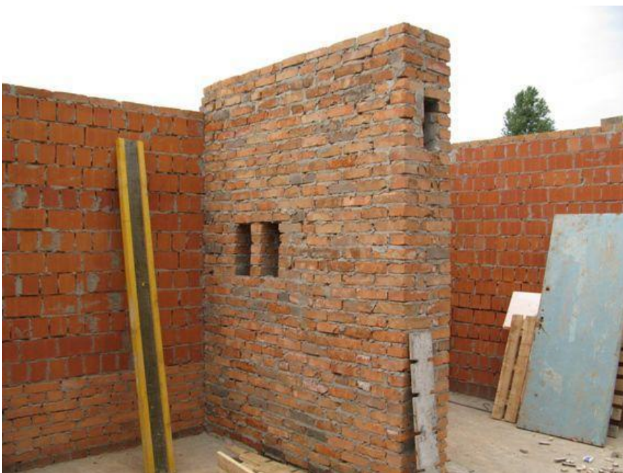
Вентиляційні канали в цегляних стінах.
