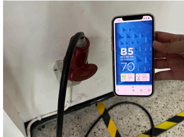
Gambar 3.15 Terminal Sambungan Acos (Sumber: Dokumentasi Pribadi)
