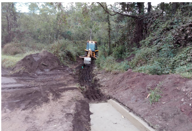
Manutenção de Drenagem próximo a Congonhas
