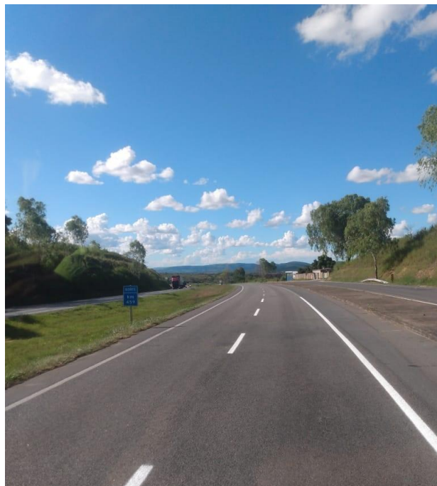
Revitalização de Pintura de Sinalização em Paraopeba
