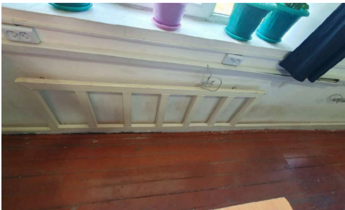
Фото 7 Тип установленных самодельных радиаторов из профилей в корпусе №2
