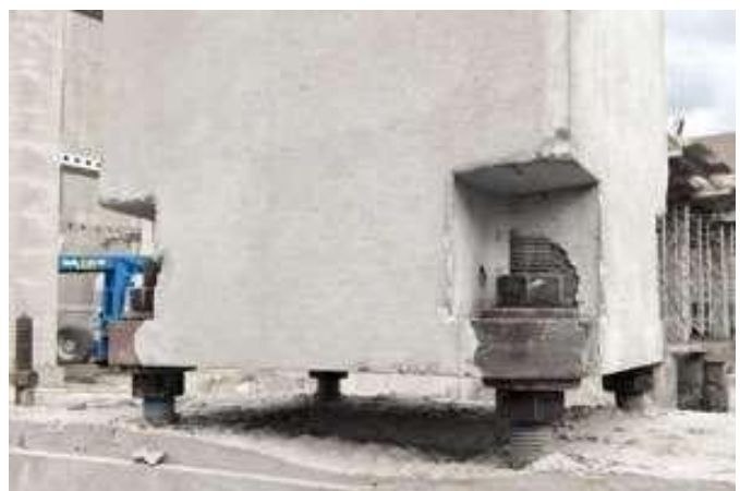
Рис. 1.2.11. З'єднання закладних деталей колон з анкерними болтами фундаментів
