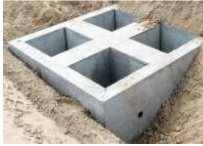
Рис. 1.2.9. Спарений фундаментний стакан (з випусками арматури)
