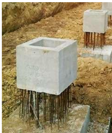
Фундаментний стакан з арматурними випусками використовується для жорсткого з'єднання з ростверком.
