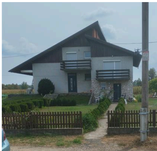
Најближи стамбени објект сјеверно (који је у власништву инвеститора)
