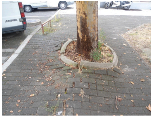
Подигање на тротоар од корен на платан
