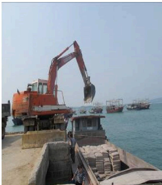
Hình 1. Hoạt động vận chuyển nguyên vật liệu xây dựng hạ tầng cơ sở trên đảo
