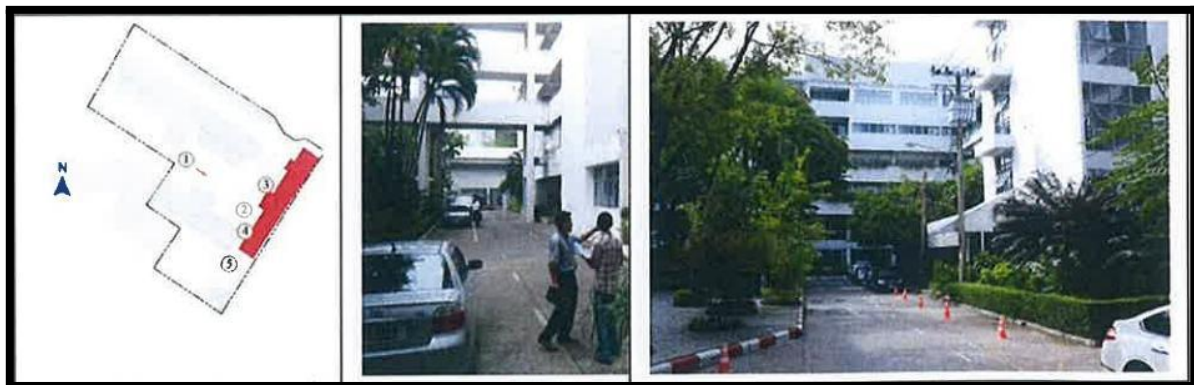
อาคาร 15 ปี สสวท. (คสล.) สูง 6 ชั้น จำนวน 1 หลัง
