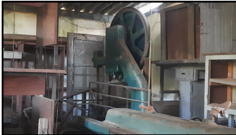
Figura 54 - Serra de fita abandonada e inacessível
