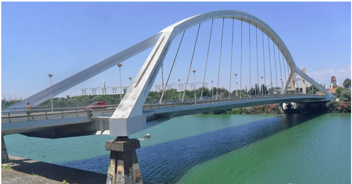
Puente de la Barqueta (Sevilla)
