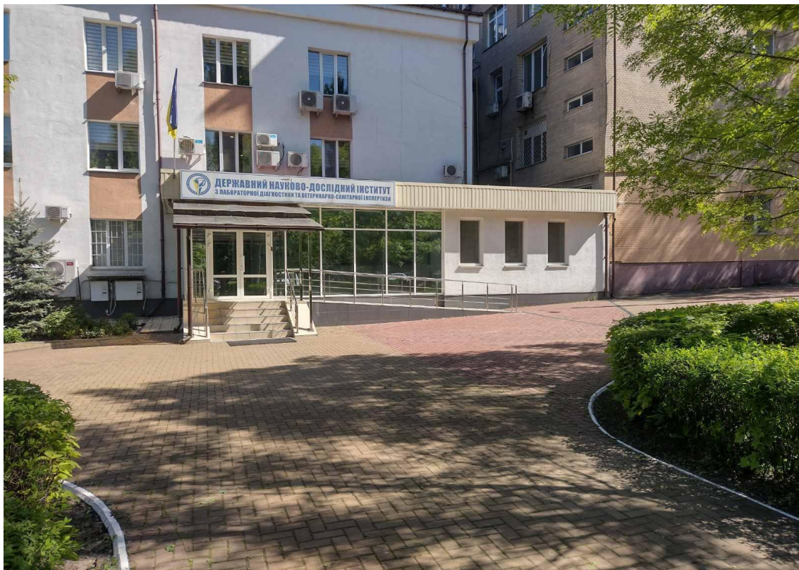
Рисунок (фото) 1. Вхід в будівлю ДНДІЛДВСЕ (головний корпус)
