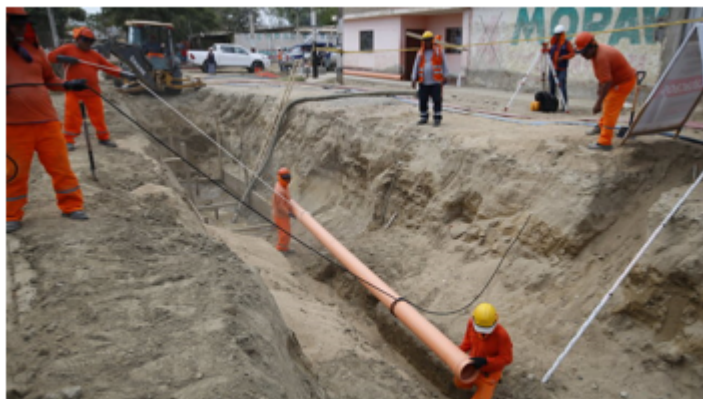
Proyecto público de saneamiento en Lima
