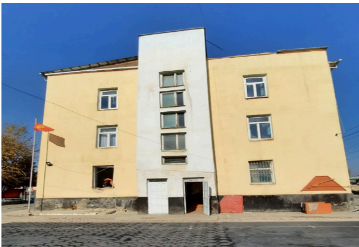
Фото 2. Общий вид корпуса № 1 с северной стороны
