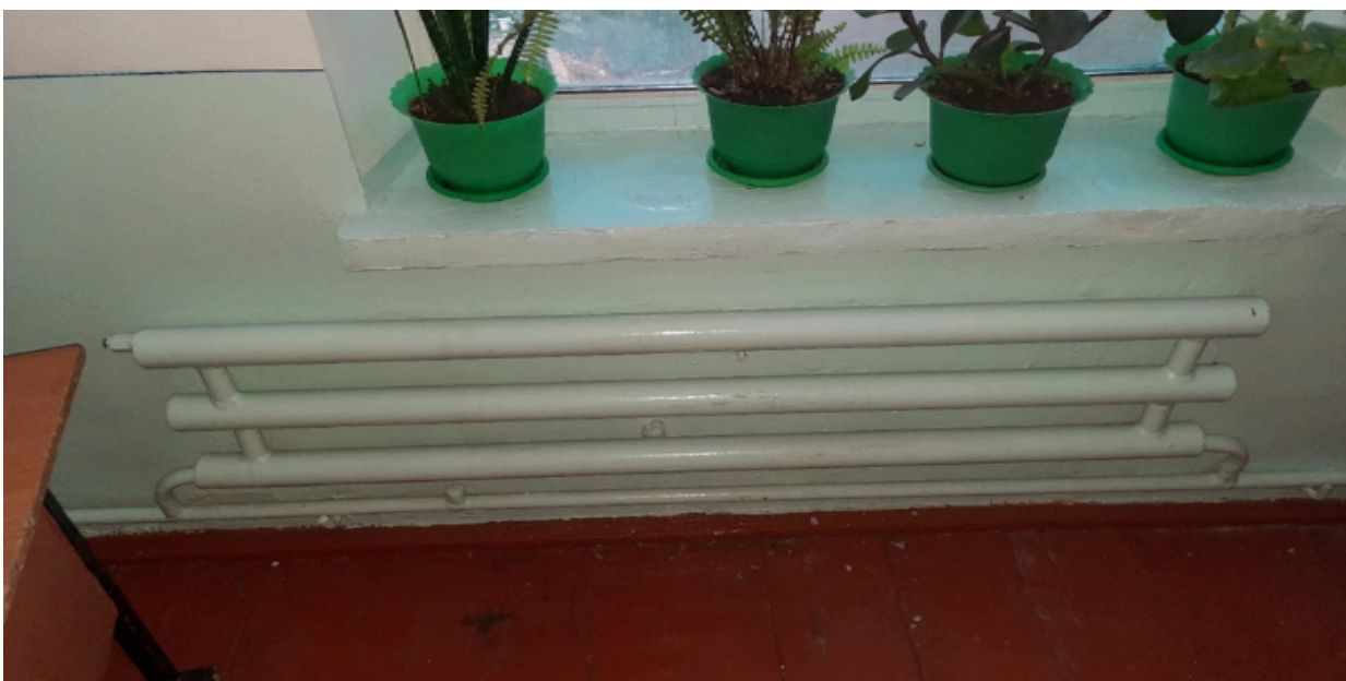
Фото 6. Самодельные трубчатые радиаторы, установленных в корпусе № 1
