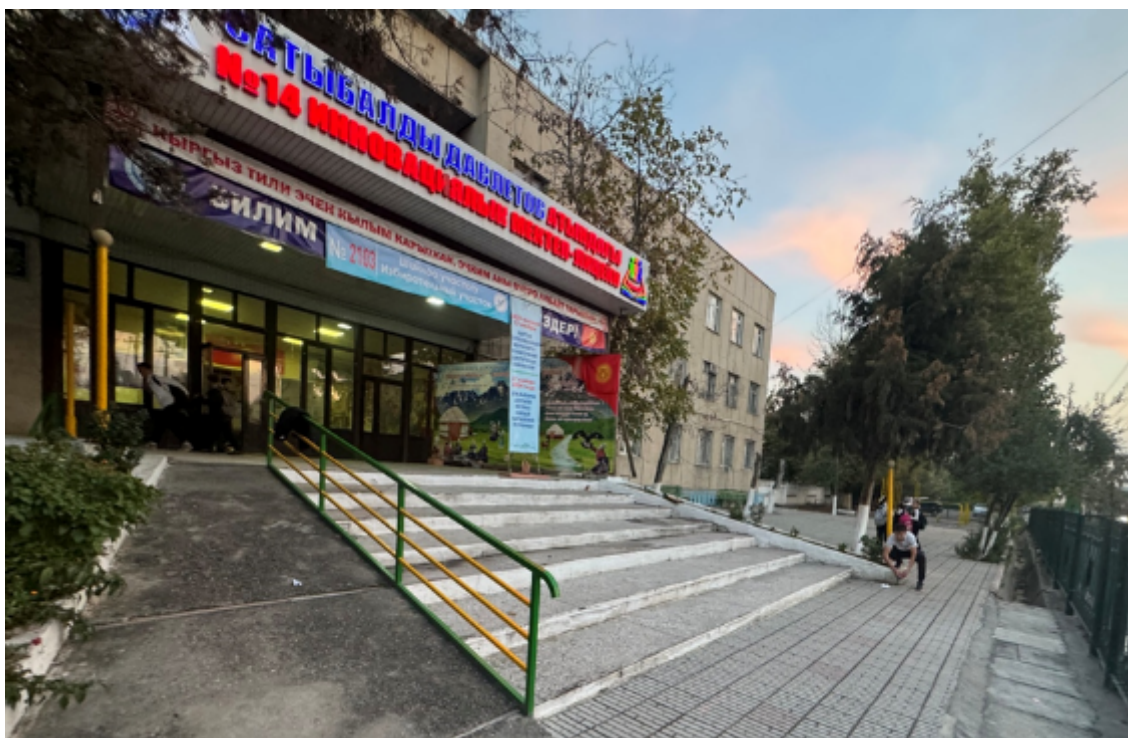
Фото 1. Общий вид корпуса № 1 с восточной стороны
