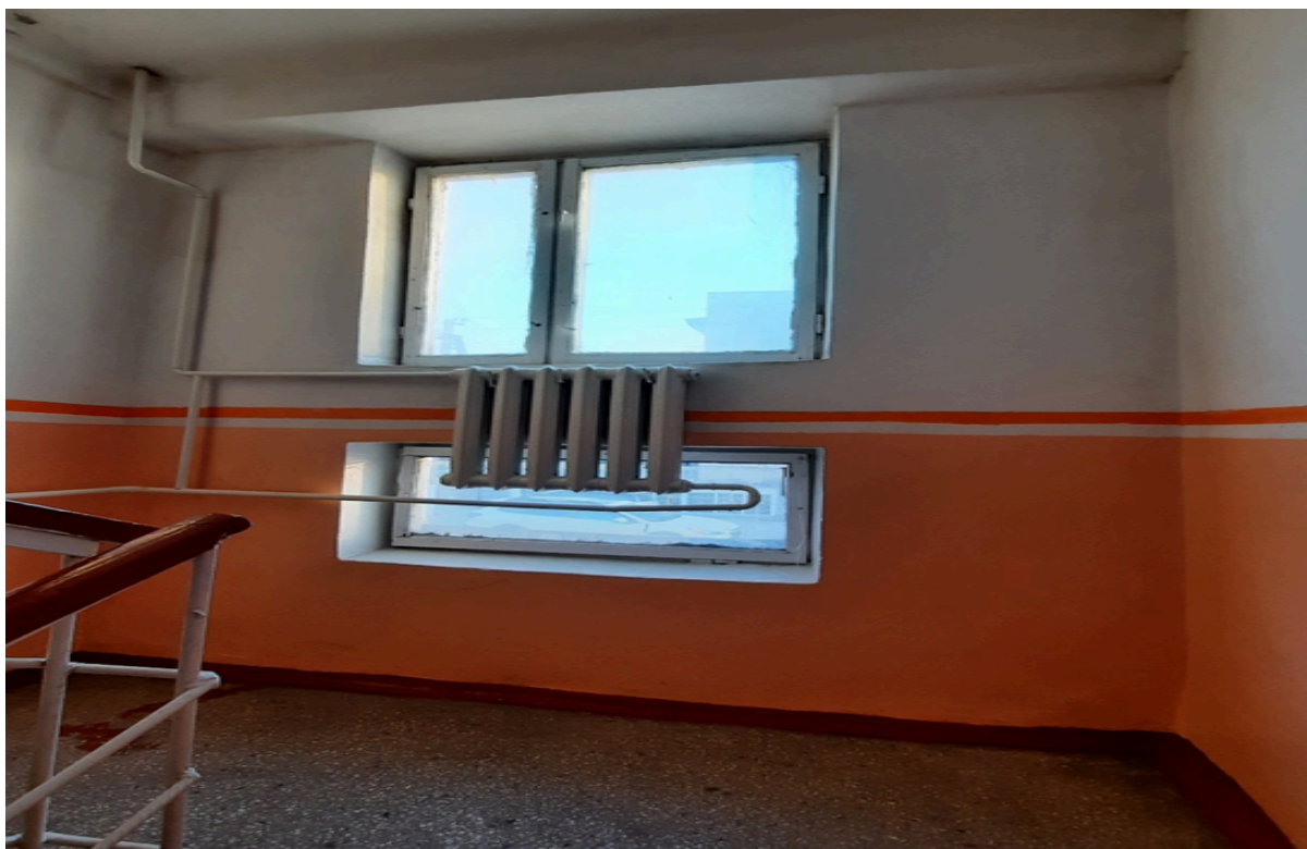
Фото 5. Тип радиаторов, установленных в корпусе № 2. Чугунные радиаторы типа МС-90.
