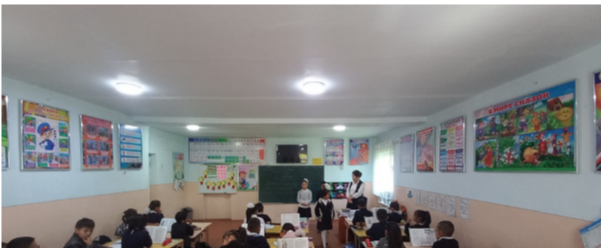
Фото 8. Отсутствует система вентиляции в классах
