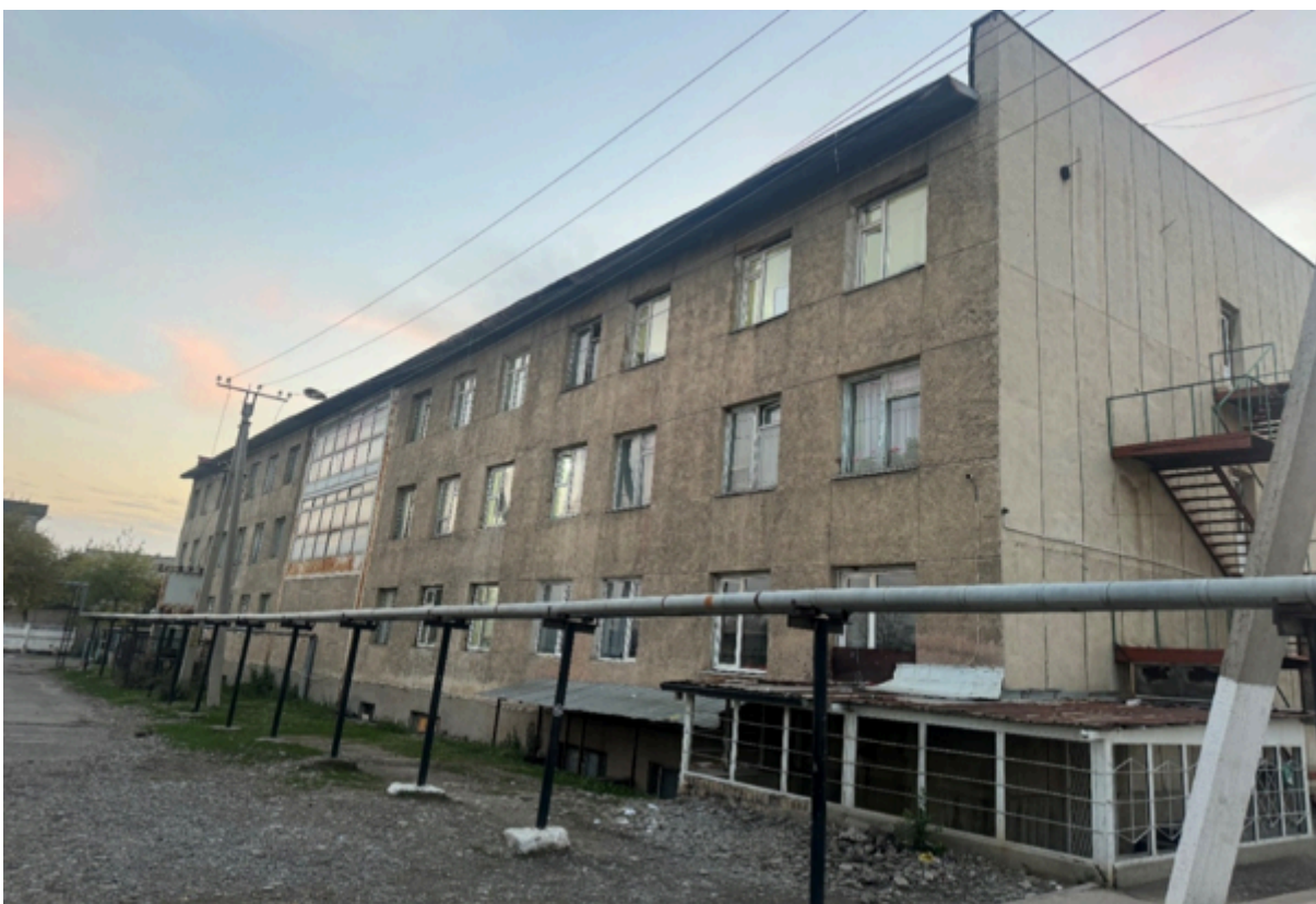
Фото 3. Общий вид корпуса № 2 с северо-восточной стороны
