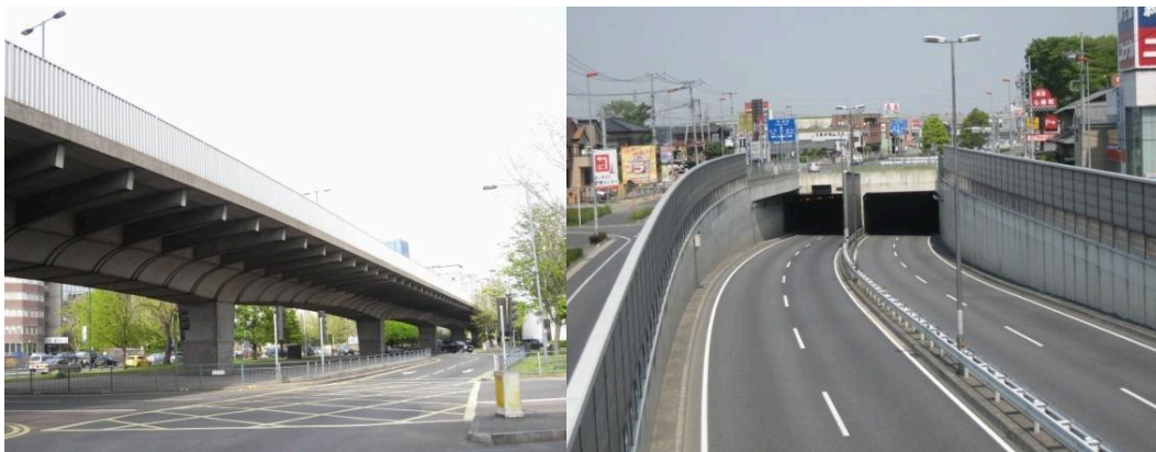
Gambar 3.1 Contoh Model Simpang Tak Sebidang (Underpass dan Flyover)
