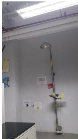
Gambar 21. Safety Shower yang dilengkapi eyewash (Sumber : Dokumentasi Pribadi)
