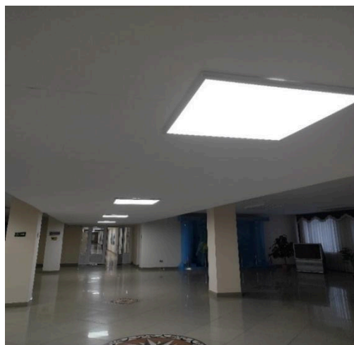
1-сурет-ҚарИУдағы энергияны үнемдейтін жарықдиодты панельдер
