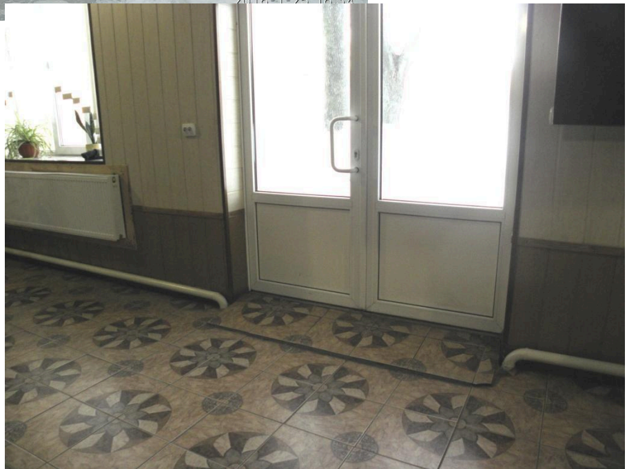
Пандус при вході у навчальний корпус
