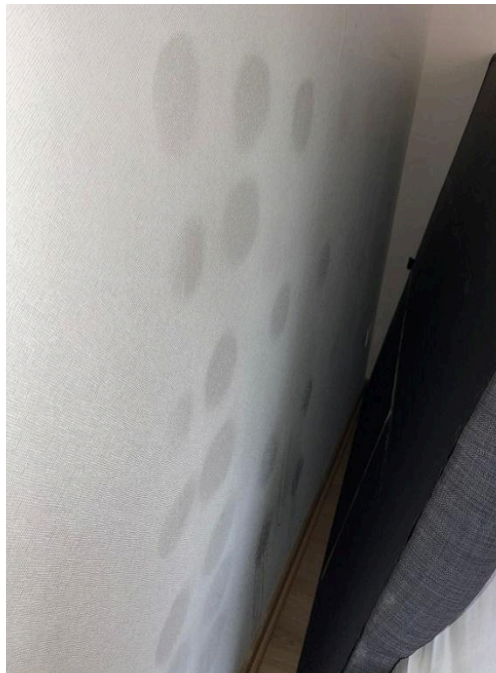
Condensación en pared tras respaldo cama
