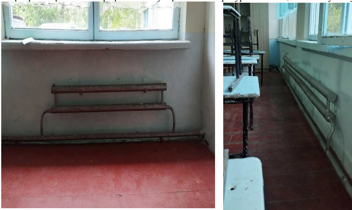
Фото 3, 4. Система отопления школы. Самодельные радиаторы
