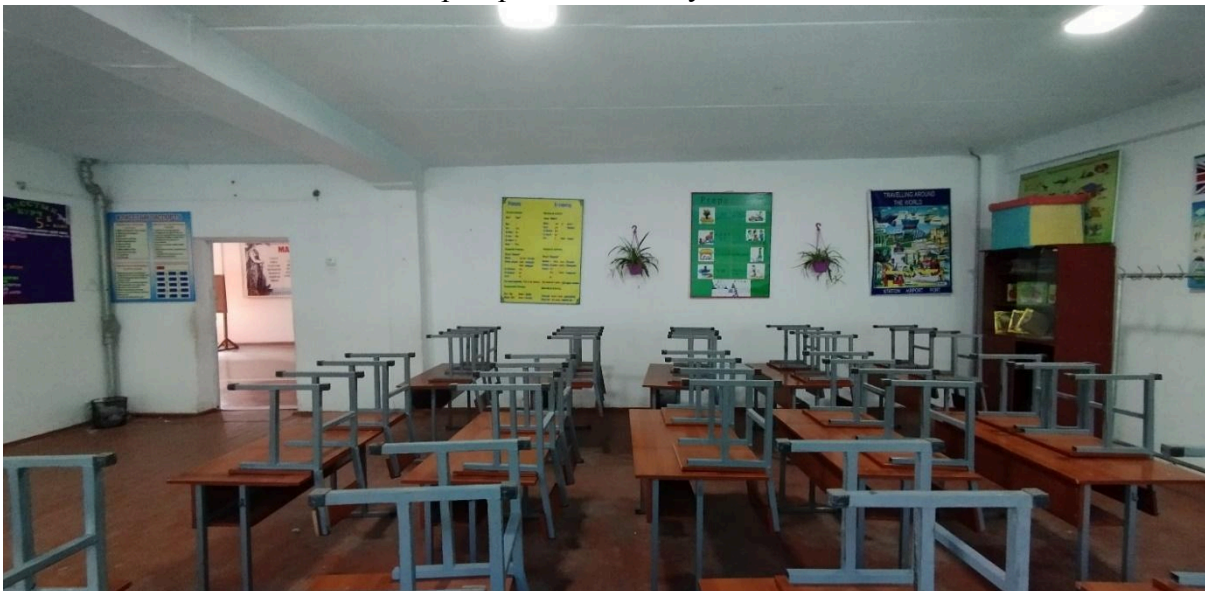
Фото 5. Отсутствует система вентиляции в классах
