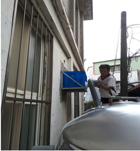
說明：過濾槽及儲水桶建置
