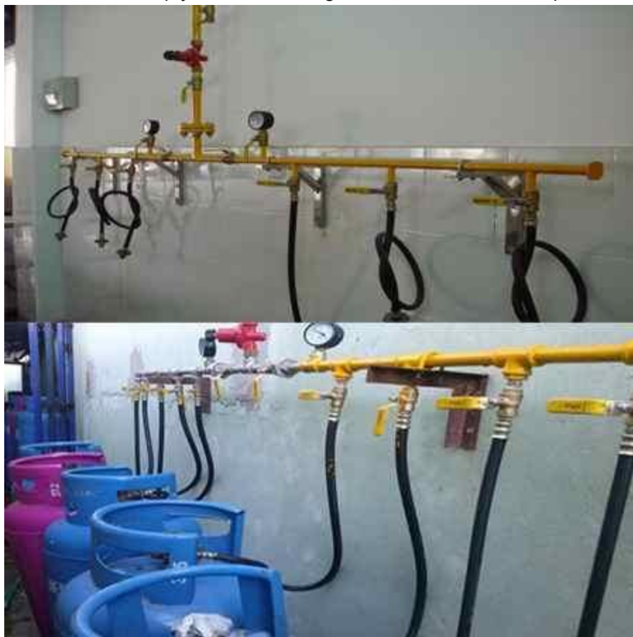
Lắp đặt khối hệ thống
