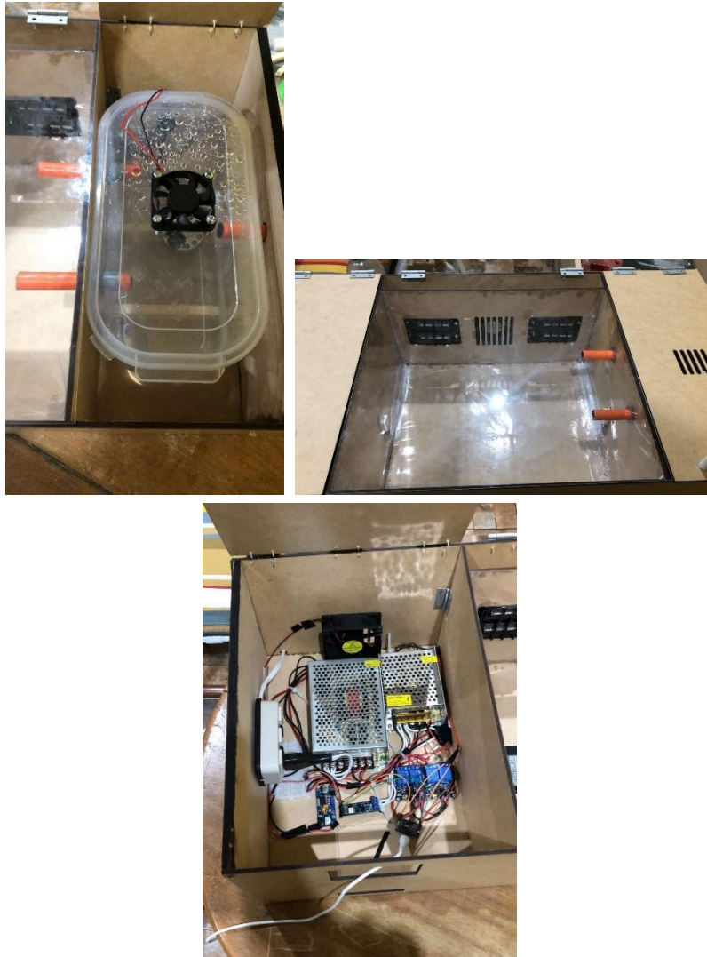
Figura 34. a) Área de humidificador. b) Área de crianza y sistema de calentador. c) Área de hardware.
