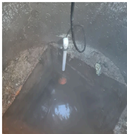
Рисунок 3 - Монтаж поплавкового датчика в выгребную яму
