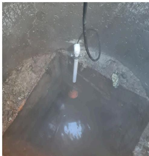
Рисунок 3 - Монтаж поплавкового датчика в выгребную яму
