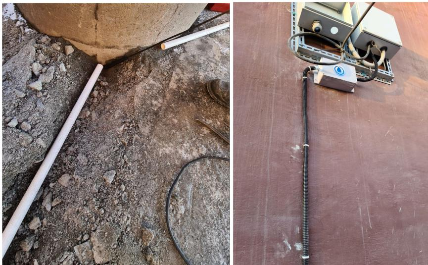
Рисунок 4 - Вывод провода датчика к контроллеру
