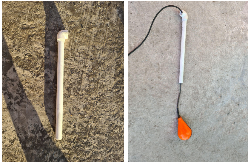
Рисунок 2 - Подготовка поплавкового датчика для монтажа в выгребную яму
