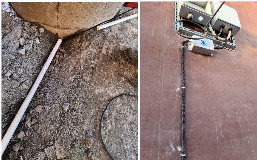
Рисунок 4 - Вывод провода датчика к контроллеру
