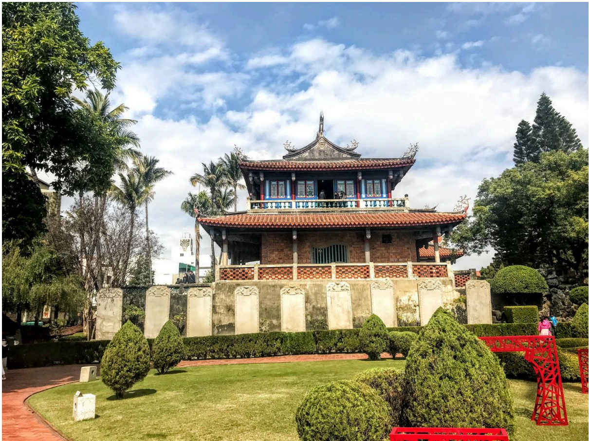
臺南赤嵌樓現況
