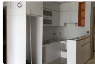
Thi công đồ gỗ nội thất chung cư theo yêu cầu - Dự án Celadon
