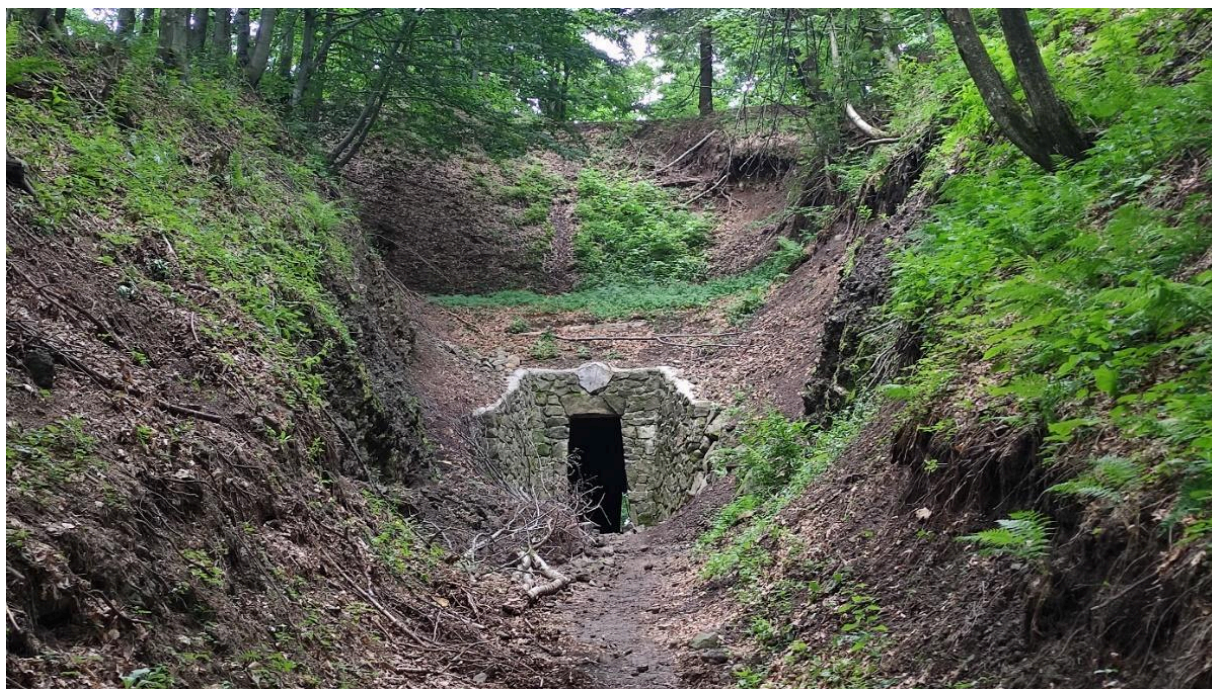
Sedlo Tunel pri Skalke
