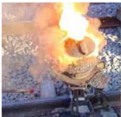
Мал. 53. Алюмотермія — відновлення металів з їх оксидів за допомогою алюмінію
