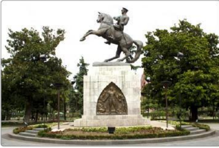
Samsun'daki Onur Anıtı'nın duruşu ve anıtın yapısal dengesi
