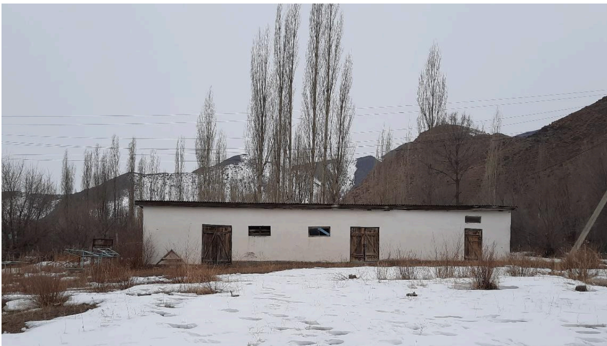
Фото 6 – Вид на корпус 6. Технические помещения
