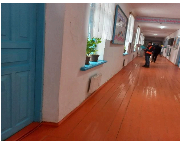
Фото 22. Тип радиаторов, используемых в здании - Бетонные электроконвекторы
