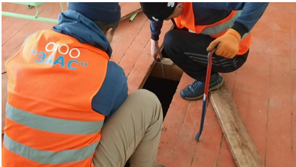
Фото 20. Фрагмент вскрытия пола корпуса №1
