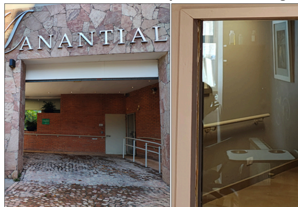
Figura 2. Pasamanos en áreas externas e internas a lo largo de los pasillos.
