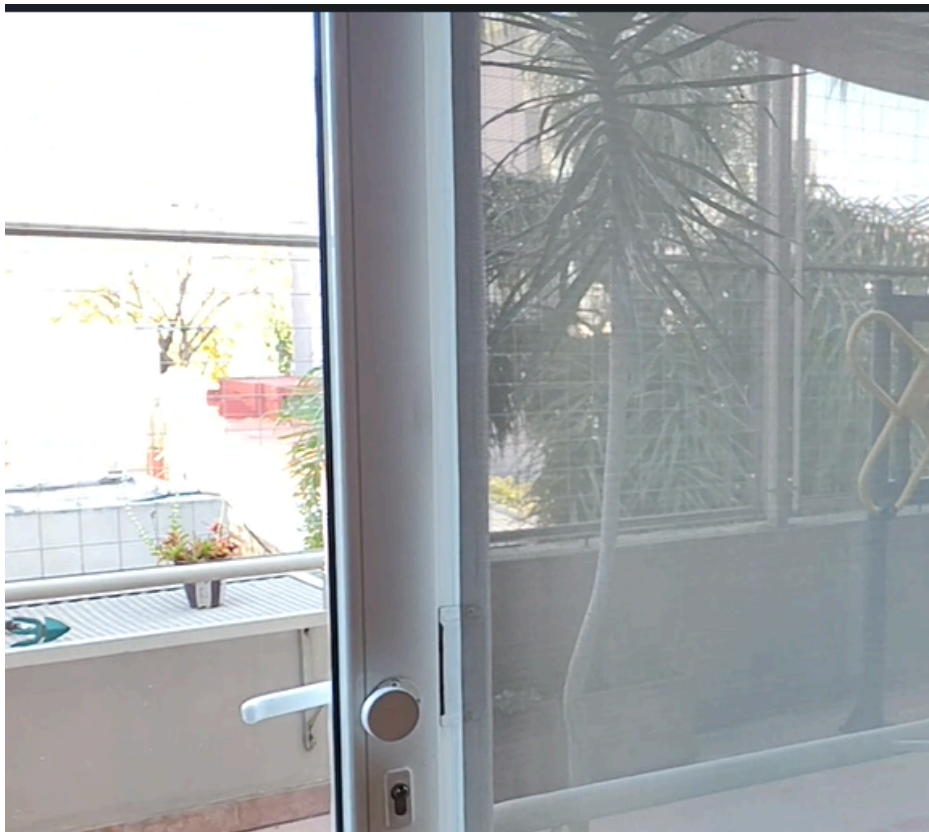
Figura 8. Detalle de una puerta.
