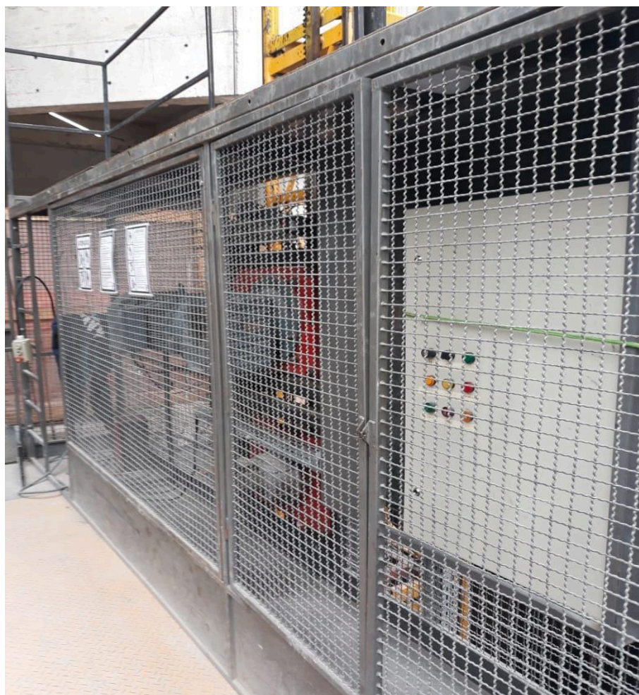
Figura 27 - Grade de proteção da base do elevador de cremalheira. Fonte: Autor
