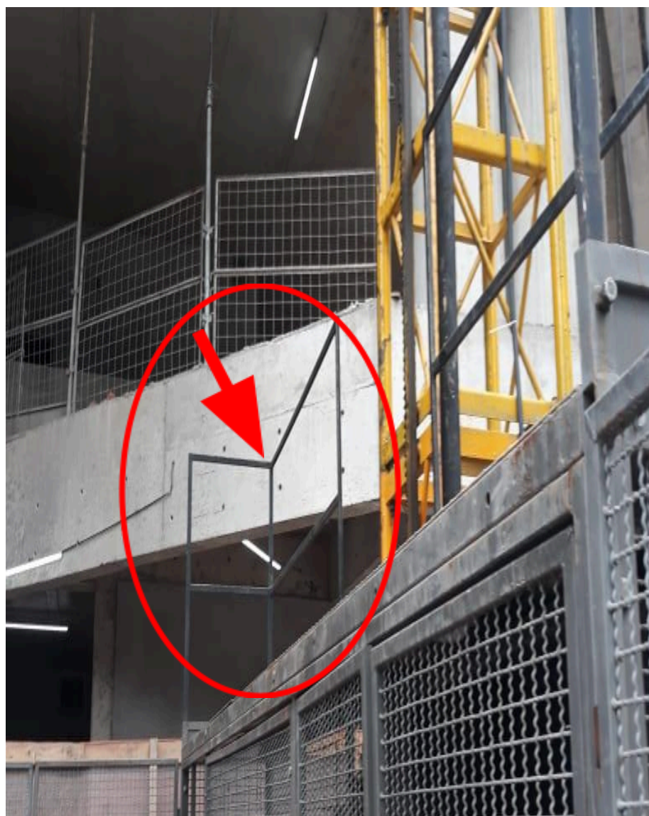
Figura 13 - Guarda corpo ou Balaustrada do elevador de cremalheira. Fonte: Autor
