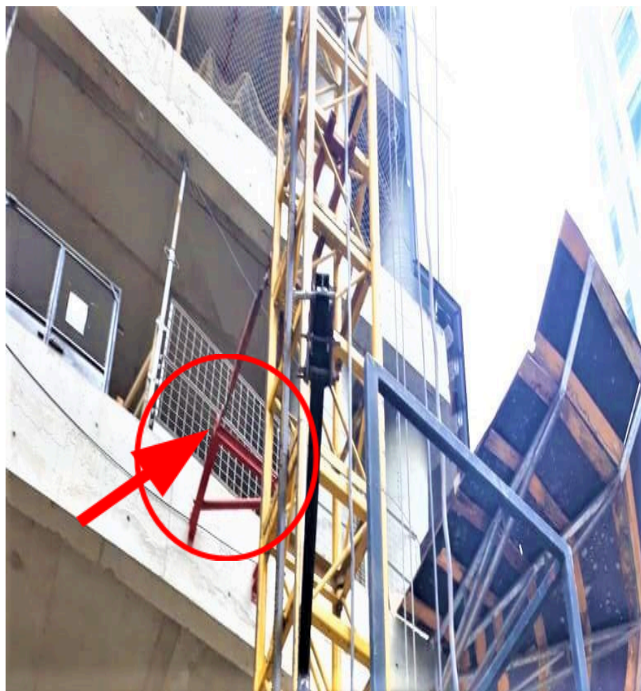
Figura 23 - Gravata ou amarração da torre do elevador de cremalheira. Fonte: Autor
