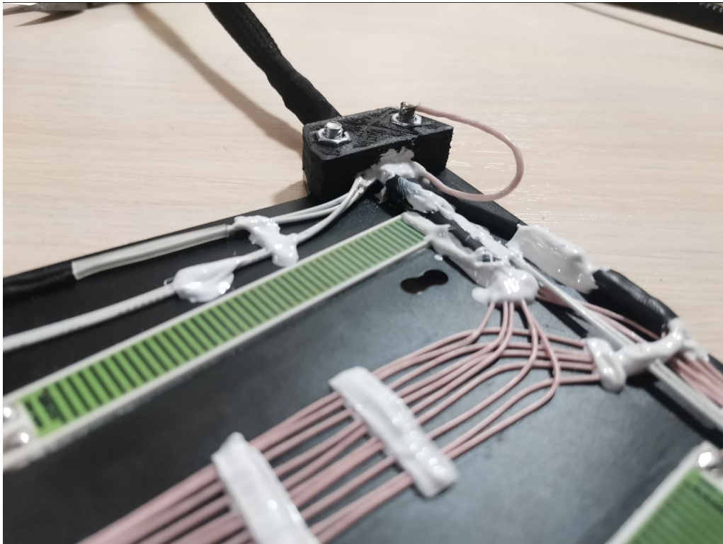
Рисунок 9д - фиксация проводов на входе в стол
