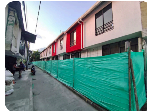
Figura 11 (Construcción de viviendas VIS- Barrio la Patria)
