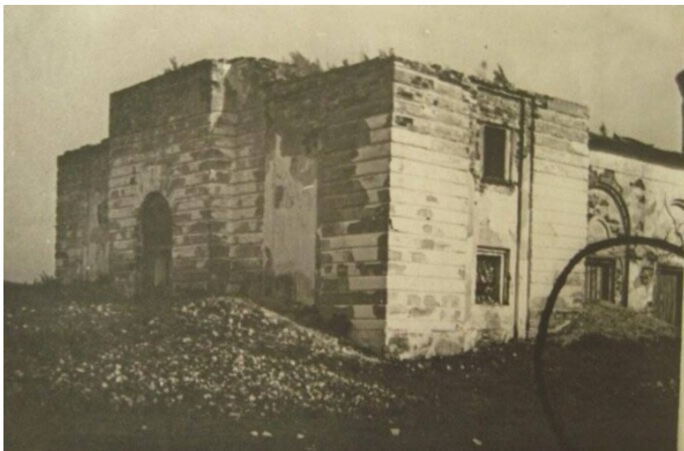
Рождественская церковь. Первый ярус разрушенной колокольни. 1947 год
