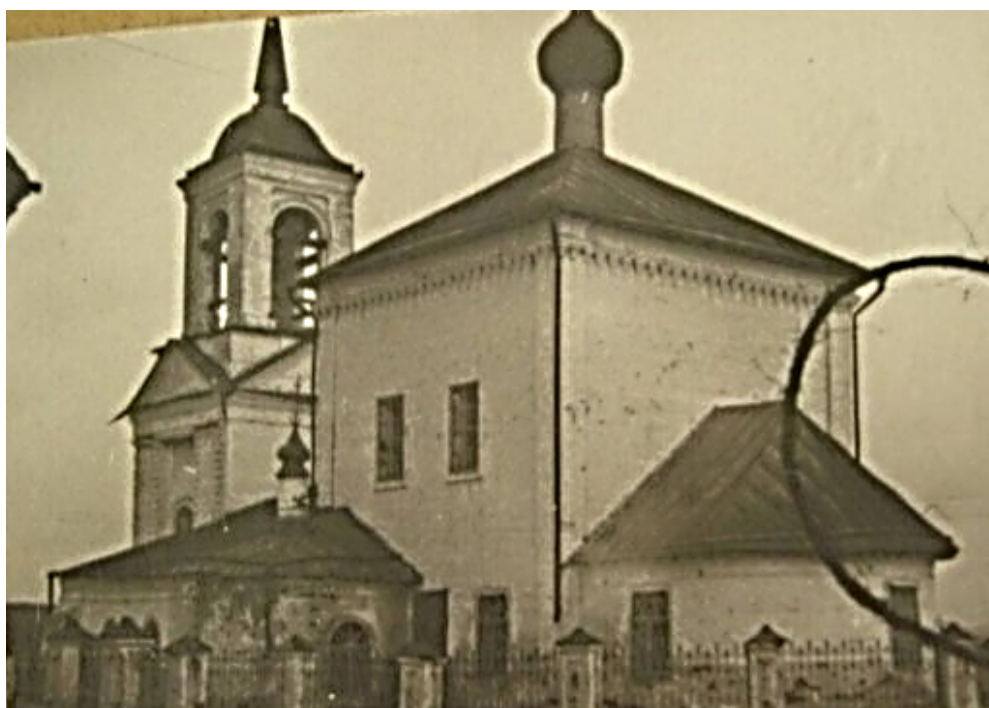
Казанская церковь. Общий вид с юго-востока. Середина XX века
