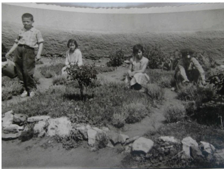
Περιποίηση του κήπου στο νεόκτιστο σχολείο
