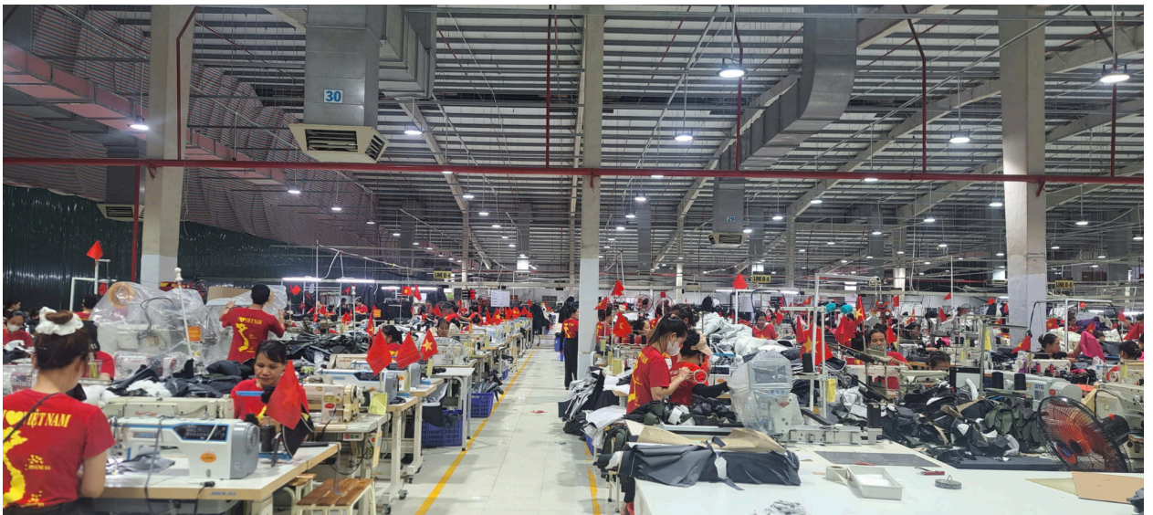
Dự án Fulian Bắc Giang (Foxconn Bắc Giang ) KCN Quang Châu, huyện Việt Yên, tỉnh Bắc Giang do Soho Lighting lắp đặt
