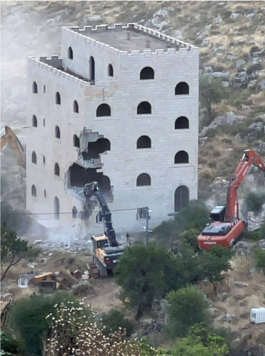
2024.05.20 베들레헴 이르타스 마을의 5층 주택을 파괴하는 HD현대 장비
