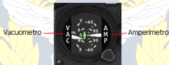
Figura 1: Amperímetro ( AMP ), nótese que la La indicación siempre se encuentra cerca de cero.
