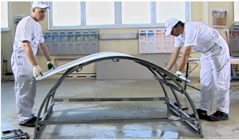
Гибка КНАУФ-листа фрезерованием
